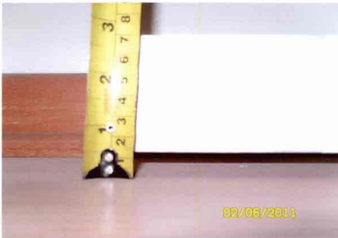
Desnivel de piso. Fotografía N° 15
