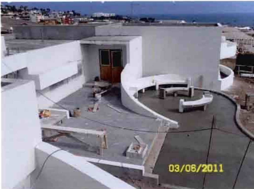
No existe rampa de acceso a minusválidos Fotografía N° 5
