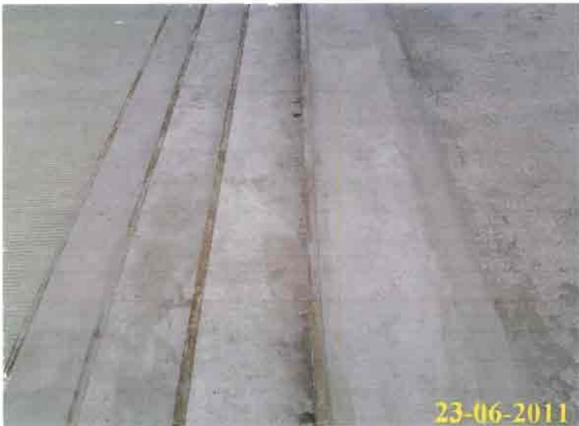
Escaleras internas cerca veletas. Fotografía N° 21
