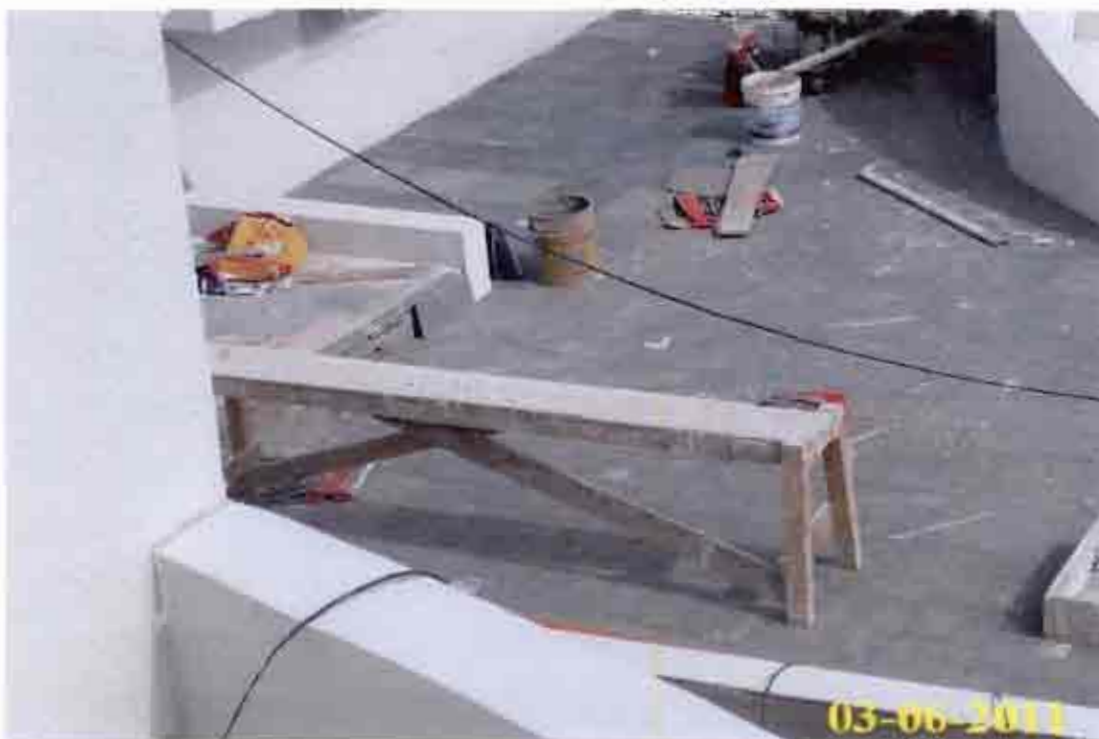
No existen franjas con textura distinta, avisando a los no videntes. Fotografía N° 6
