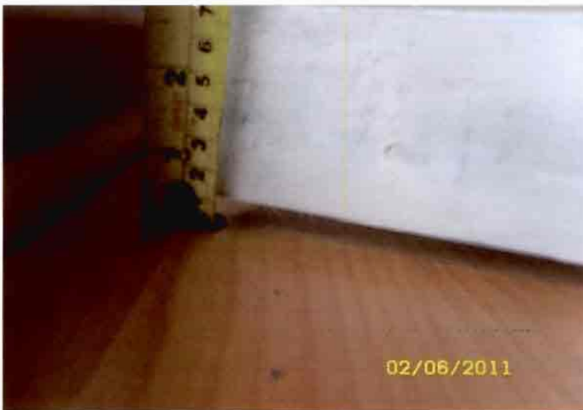
Desnivel de piso. Fotografía N° 14
