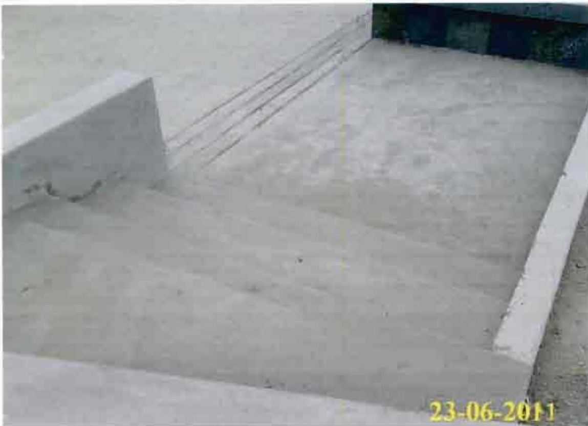
Escaleras. Fotografía N° 19
