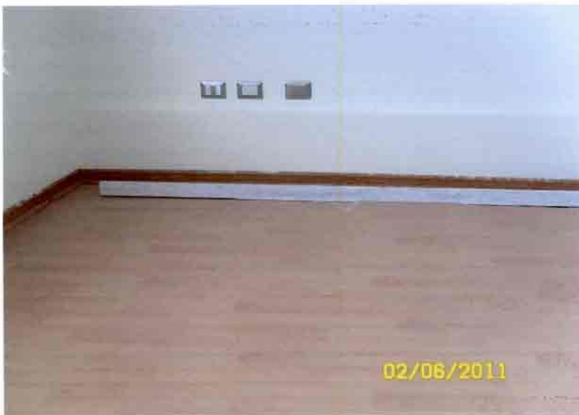
Desnivel de piso. Fotografía N° 16
