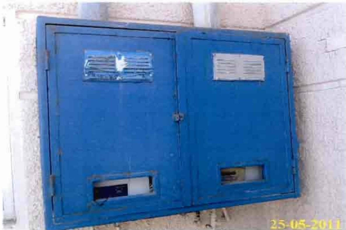
Calefón, Fotografía N° 2
