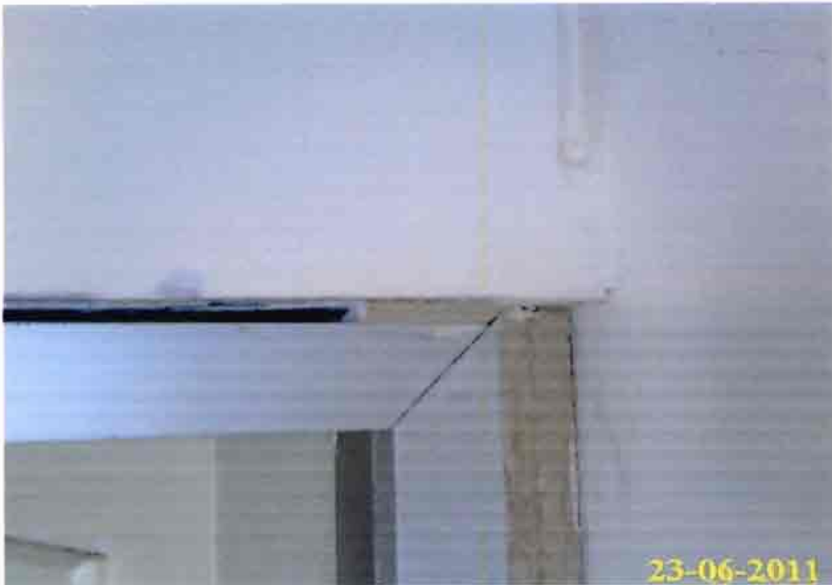
Fibromadera en marcos de puertas. Fotografía N° 18
