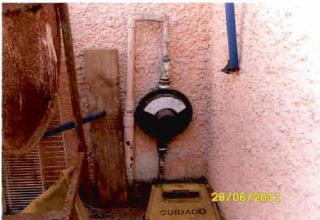
Regulador de gas, sin caseta. Fotografía N° 3
