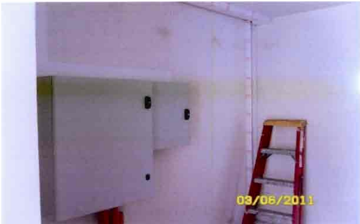
Closet para tableros eléctricos. Fotografía N° 8
