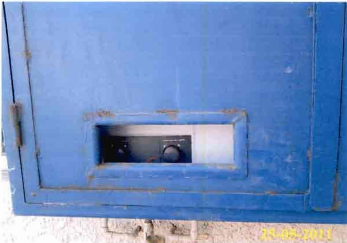
Caseta Calefón. Fotografía N° 1
