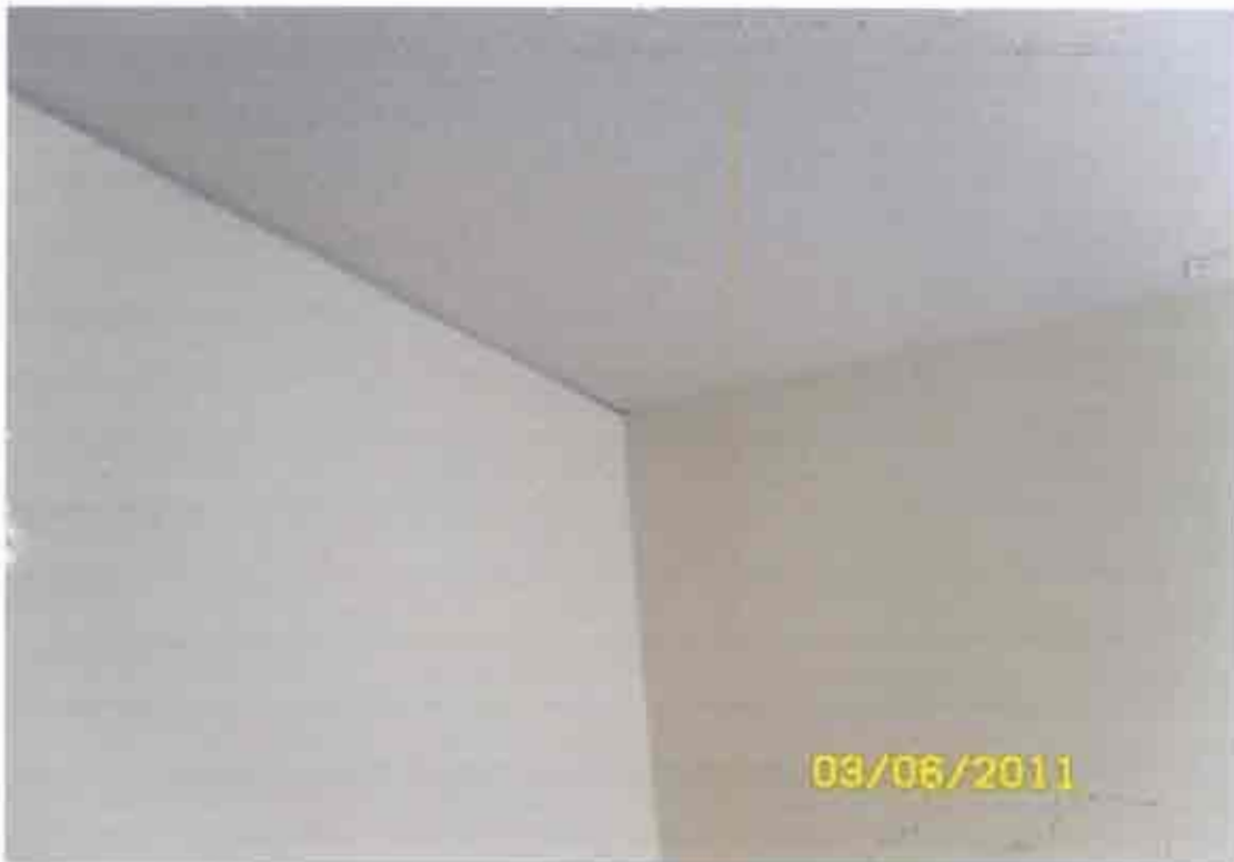
Canterías 2x2 cm. Fotografía N° 12
