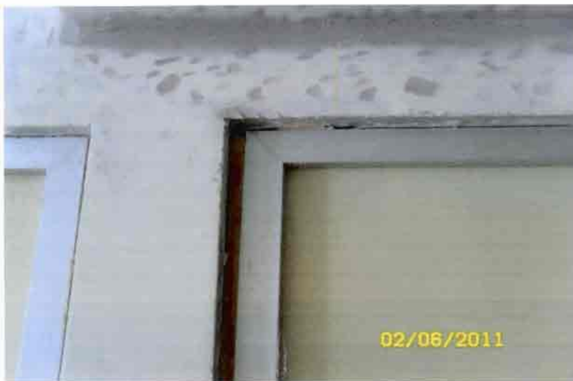
Listones de fibromadera en marcos de puertas. Fotografía N° 17
