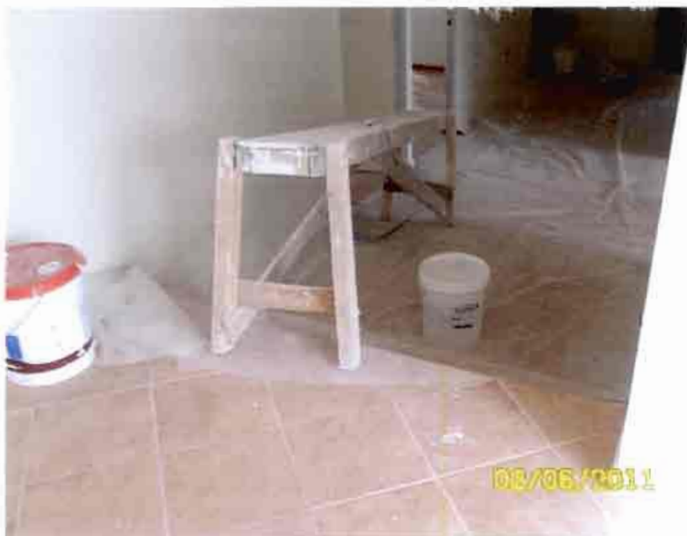
El desnivel del pasillo interior, es mucho mayor a dos centímetros. Fotografía N° 7
