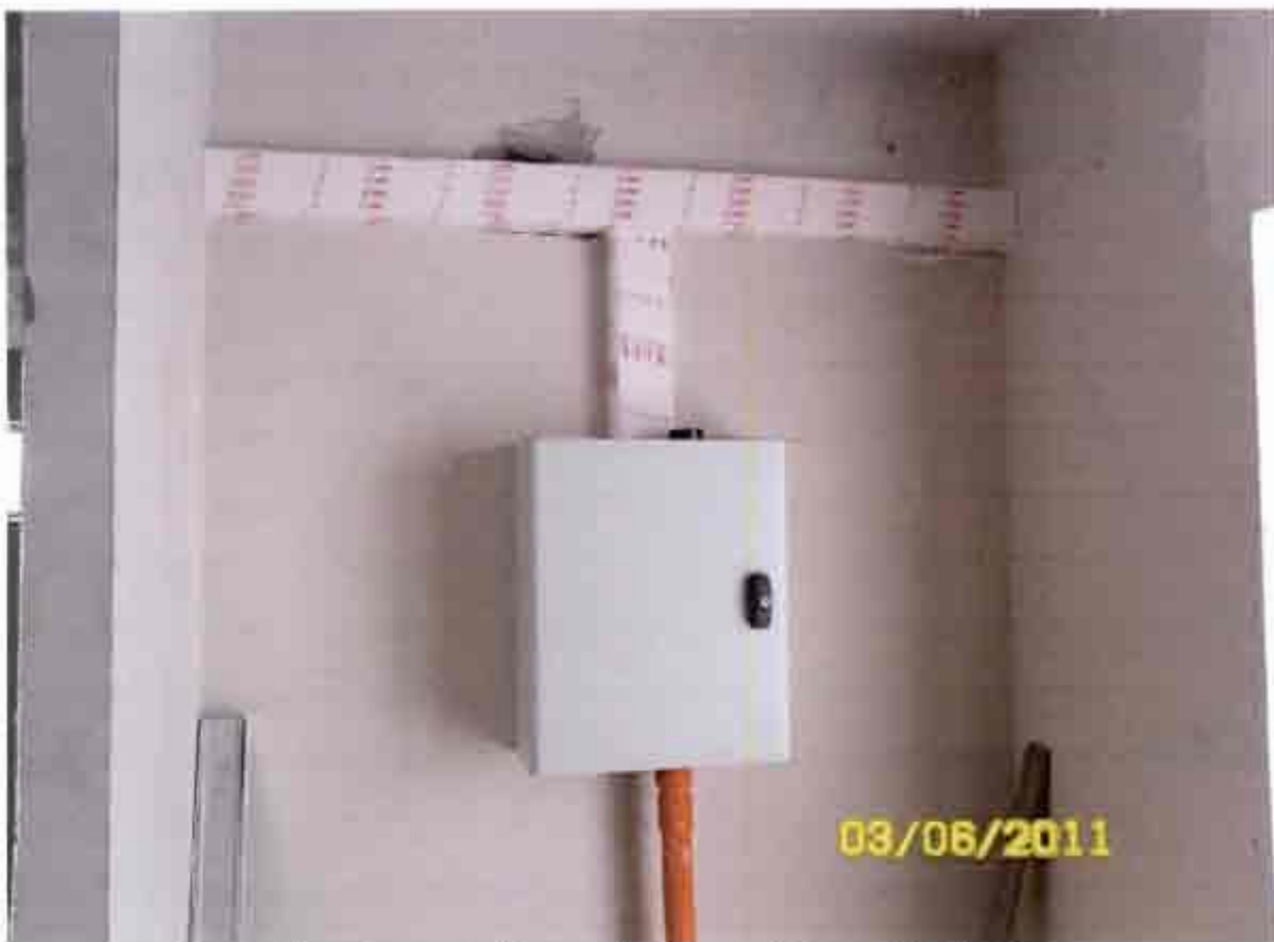
Closet para tableros eléctricos. Fotografía N° 9
