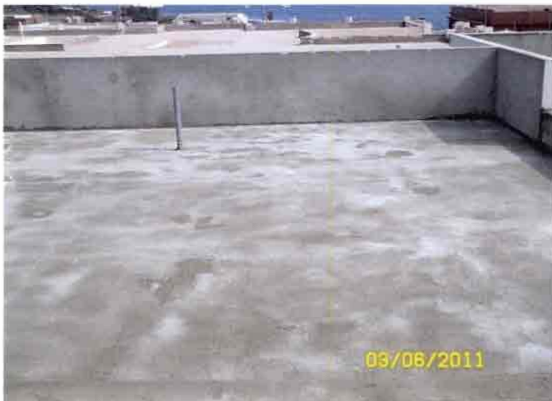
Impermeabilización losa cielo. Fotografía N° 10
